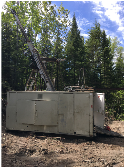
Figure 1: Plate-forme de forage au diamant positionnée sur le trou numéro un
